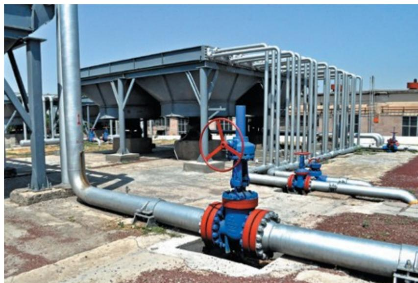
Рис. 2. Аппараты воздушного охлаждения газа
